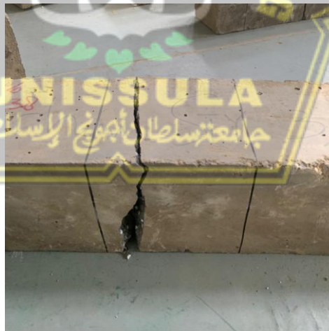
Gambar 4. 9 Pola retakan pada beton styrofoam
