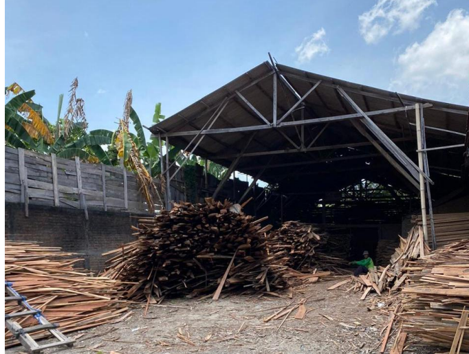
Gambar 4.1 Stasiun Kerja Gudang Bahan Baku
