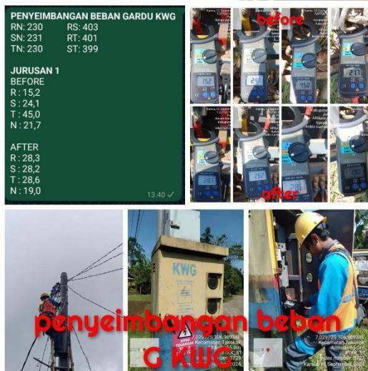
Gambar 4. 15 Penyeimbangan Gardu KWG Gambar 4. 16 Pengukuran Gardu KWG
