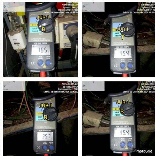
Gambar 4. 15 Penyeimbangan Gardu KWG Gambar 4. 16 Pengukuran Gardu KWG
