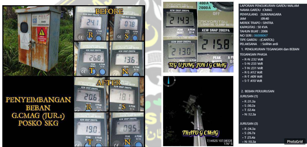
Gambar 4.11 Penyeimbangan Gardu CMAG Gambar 4.12 Pengukuran Gardu CMAG
