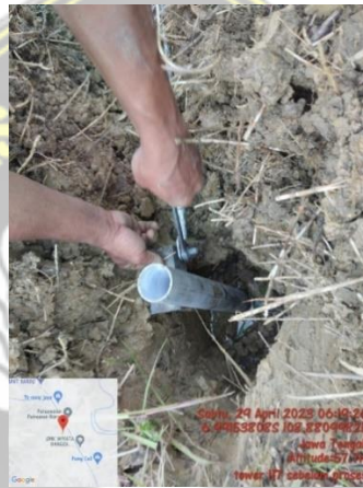
Gambar 4. 6 Menghubungkan ground rod dan kaki tower dengan earth wire
