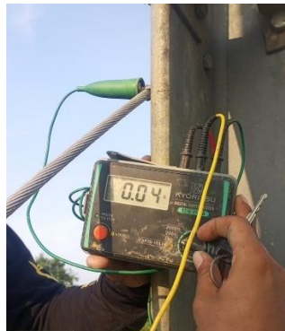
Gambar 4. 7 Menguji tahanan pentanahan tiap kaki tower setelah pemasangan MRG
