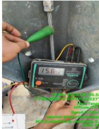
Gambar 4. 3 Menguji tahanan pentanahan tiap kaki tower sebelum pemasangan MRG
