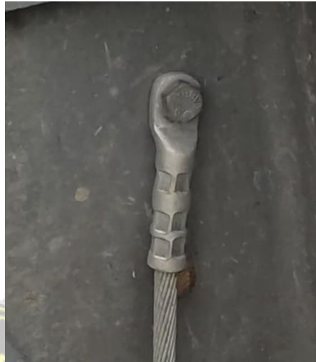
Gambar 2.9 Sepatu kabel ( skun ) untuk MRG [15]
