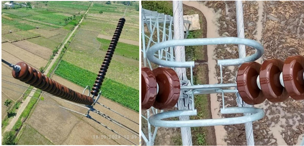
Gambar 4. 13 Kondisi isolator yang baik setelah dilakukan pemasangan MRG pada tower 171
