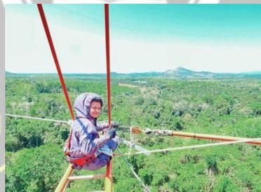
**Gambar 2.1** Pemeliharaan Isolator secara PDKB dengan Metode *Barehand*
