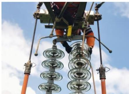
**Gambar 1.1** Pekerjaan dalam Kondisi Bertegangan
