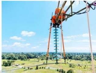
**Gambar 2.2** Pemeliharaan Isolator secara PDKB dengan Metode *Hotstick*
