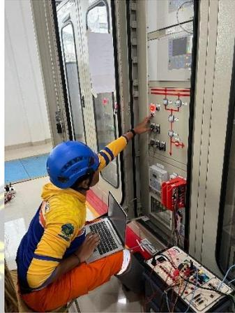
Gambar 4. 12. Proses Pengujian Relay
