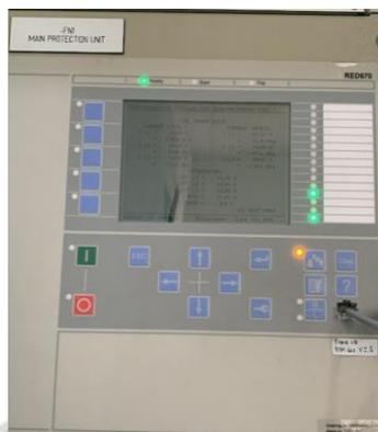
Gambar 4. 4. Relay ABB RED670
