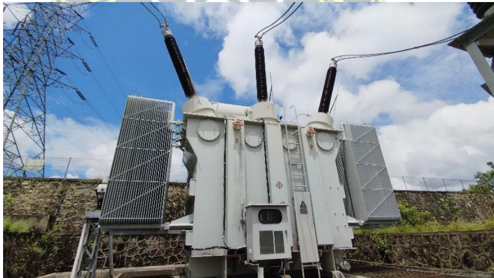
Gambar 3. 4. Reaktor 275 kV GITET Bengkayang
