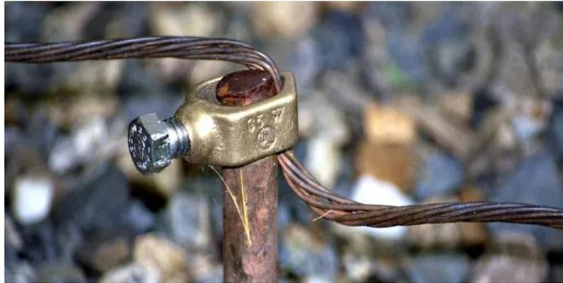
**Gambar 2. 2 Elektroda Pentanahan.**
