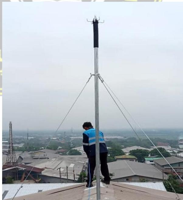
**Gambar 2. 10** pemasangan terminasi udara jenis elektrostatis
