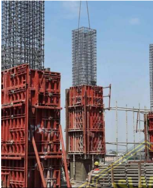
Gambar 3. 1 Bekisting Sistem
