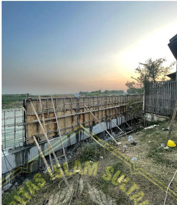
**Gambar 2.2.** Pengerjaan Bekisting
