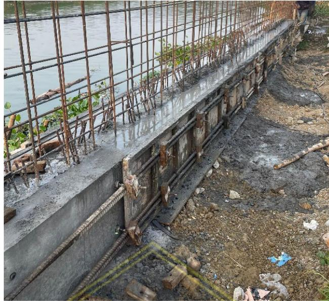
**Gambar 2.2.** Pengerjaan Beton mutu K100
