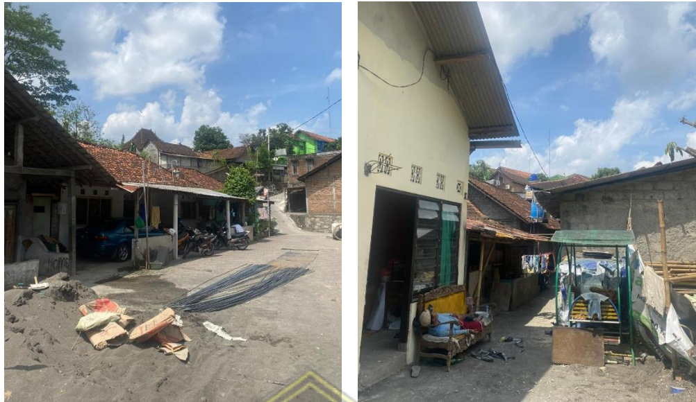
Gambar IV. 7 Kondisi Bangunan Rumah di Sempadan Sungai
