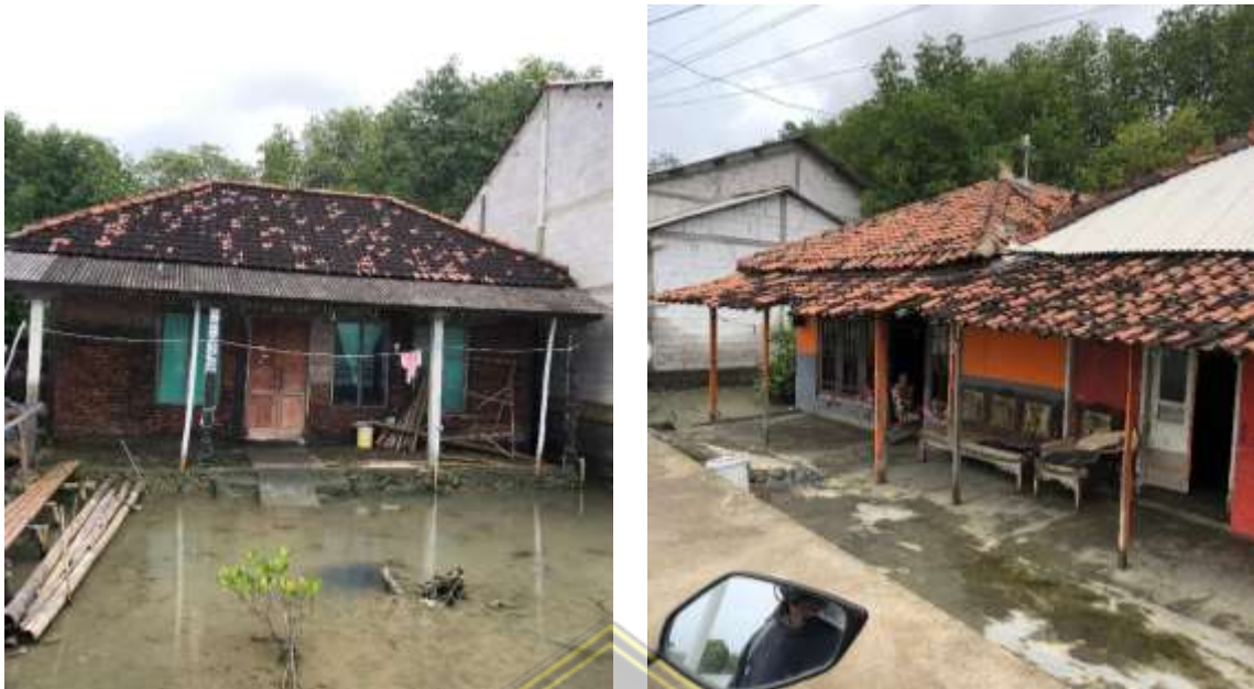
Gambar 4. 5 Kondisi Bangunan Rumah di Desa Morodemak
