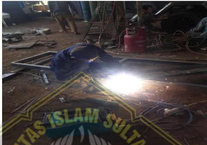
Gambar 4.2 Proses Pengelasan atau Perakitan
