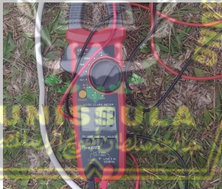
Gambar 5. 7 Pengukuran tegangan tersambung pada beban dan kapasitor
