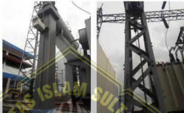
Gambar 2. 14 Struktur penyangga Lightning Arrester [9]
