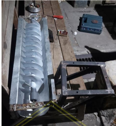
Gambar 3. 9 Pengaplikasian turbin ke generator
