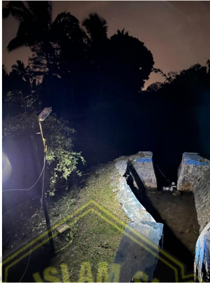
Gambar 5. 11 Lampu penerangan pada dekat turbin
