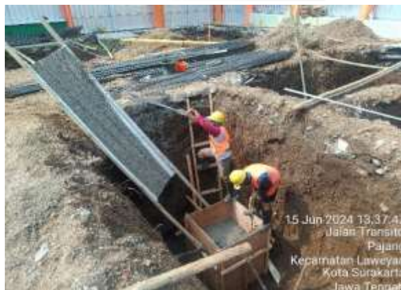
Gambar 4.7. Pengecoran Sumuran
