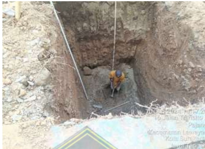
Gambar 4.4. Pekerjaan Galian Manual Sumuran
