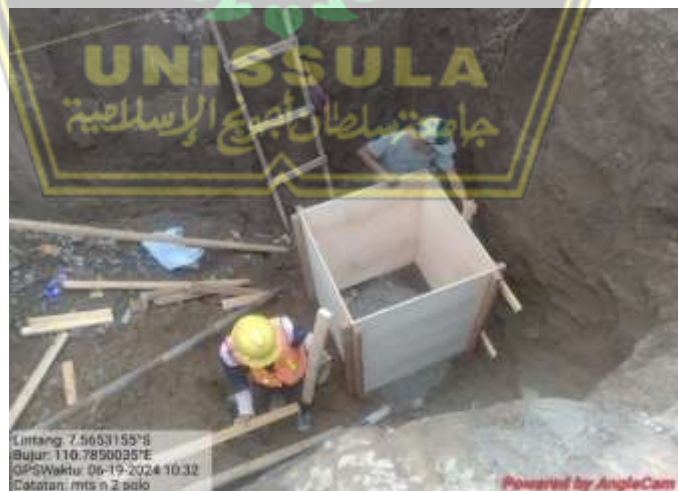
Gambar 4.5. Pemasangan Bekisting Sumuran
