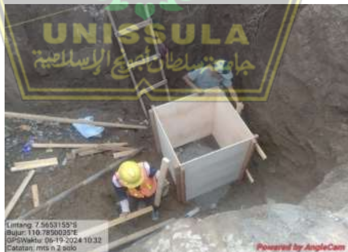
Gambar 4.5. Pemasangan Bekisting Sumuran
