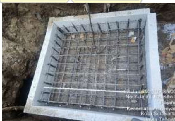
Gambar 4.9. Pembesian Foot Plat
