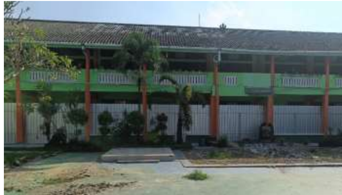
Gambar 4.2. Pekerjaan Pembersihan Lahan
