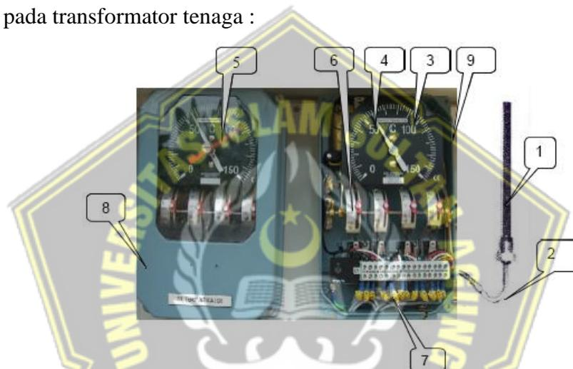
**Gambar 2.4** *Relay* Suhu Trafo
