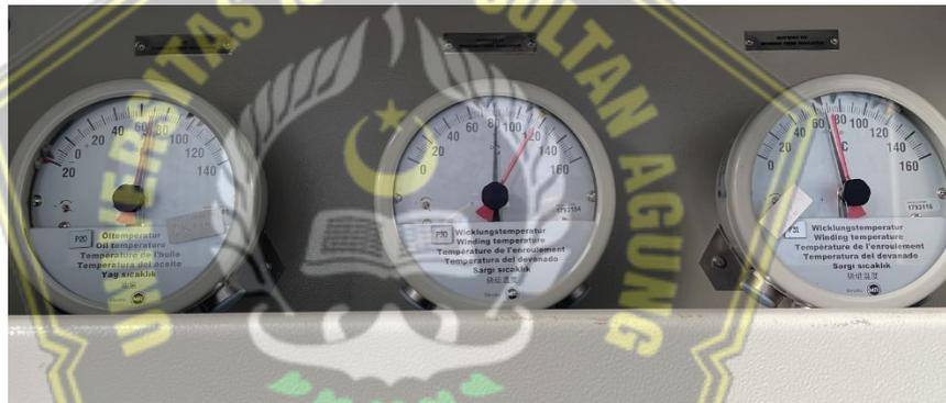
Gambar 4.4 Relay Thermal Trafo Tenaga
