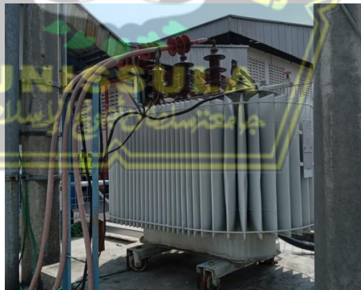
gambar 2. 6 Trafo 630kVA
