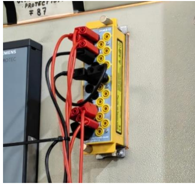
Gambar 3.16 Pemasangan Test Plug pada Test Block Relai
