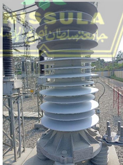
Gambar 4.14 Isolator LA setelah pemeliharaan
