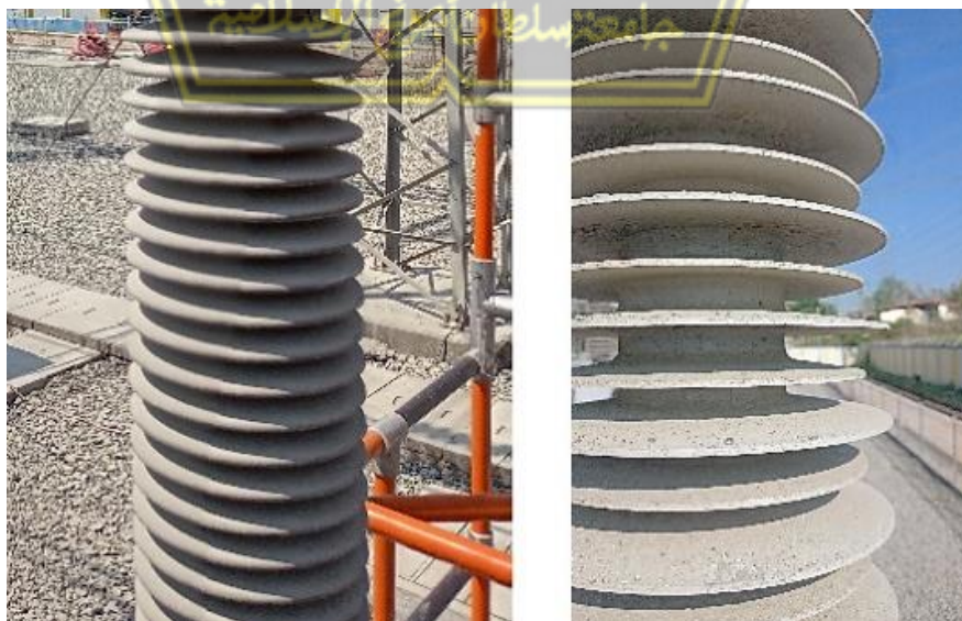
Gambar 2.5 Foto isolator terkontaminasi polutan semen
