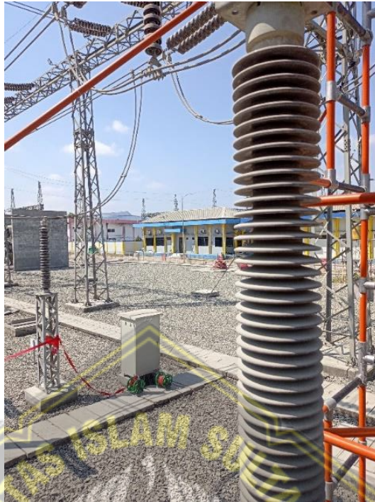
Gambar 4.7 Isolator bay Rembang 1 bus 2 sebelum pemeliharaan
