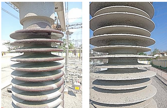
Gambar 4.5 Foto isolator keramik dan karet silikon pada kondisi sebelum pemeliharaan dalam keadaan basah
