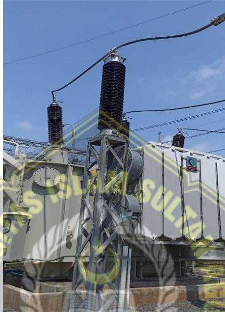
Gambar 3. 4 Lightning Arrester gardu induk 150 KV New Batang
