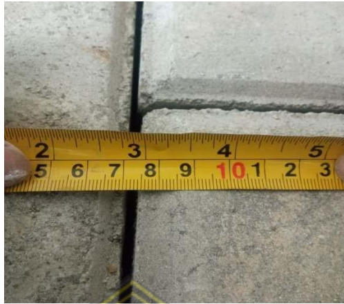
Gambar 4.7. Pemasangan paving holland dengan jarak jointing sand 5.00 mm (Sumber: Dokumentasi penulis)
