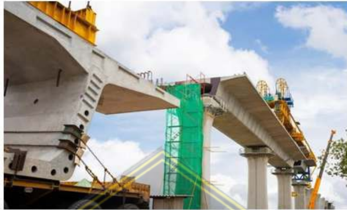
Gambar 2.4 Jembatan Beton Prategang
