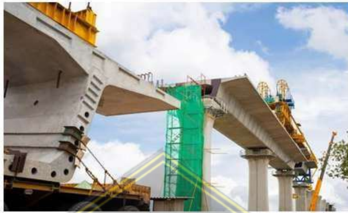
Gambar 2.4 Jembatan Beton Prategang
