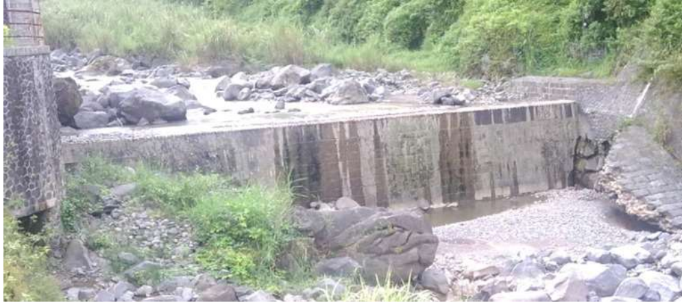
Gambar 2. 1 Bendung Tyroll
