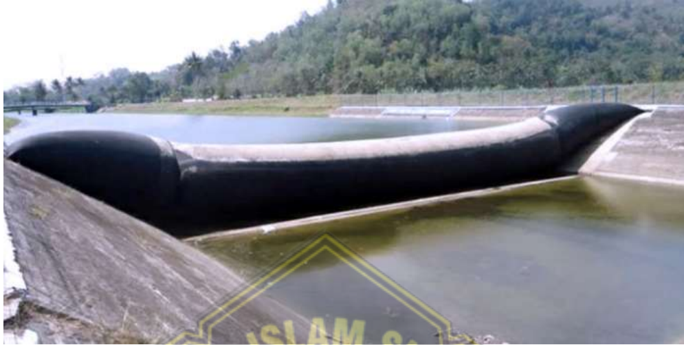
Gambar 2. 4 Bendung Gerak Karet
