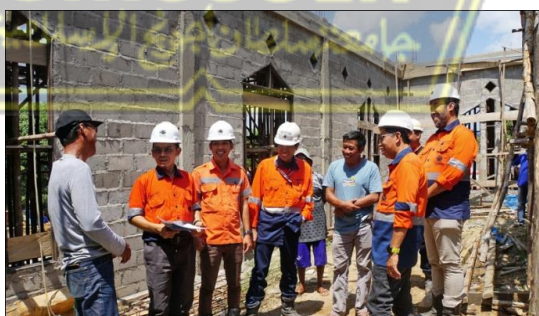
Gambar 3. 3 Bantuan Renovasi Pembangunan Masjid di Desa Dugan
