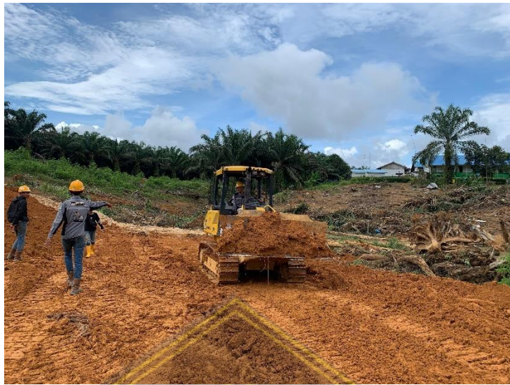
Gambar 4.4 Bulldozer Berhenti Bekerja Karena Pengarahan
