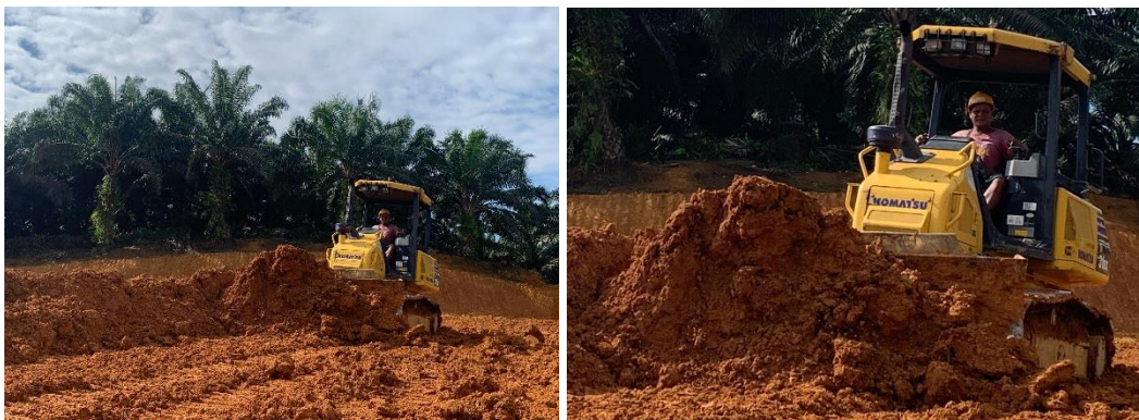
Gambar 4.7 Blade Bulldozer Terisi 100% oleh Material Tanah
