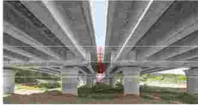
Gambar 2.8 Jembatan Beton Prategang
