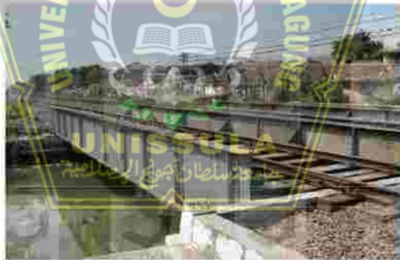
Gambar 2.2 Jembatan Gelagar Pelat
