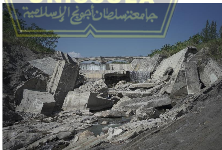
Gambar 1.1. Kerusakan bangunan akibat perubahan morfologi sungai (Sumber: Dokumentasi Pribadi)
