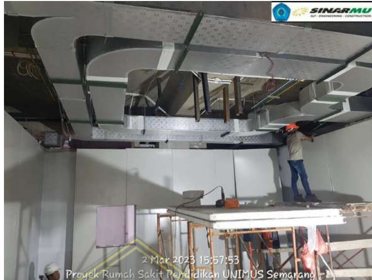
Gambar 4.7 Pekerjaan MEP Gedung 9 Lantai
