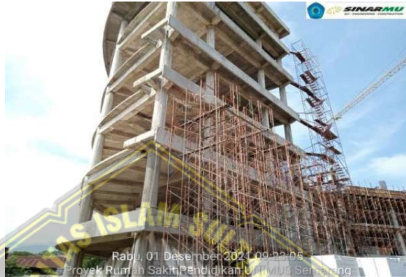
Gambar 4.5 Pekerjaan Struktur Gedung 9 Lantai
