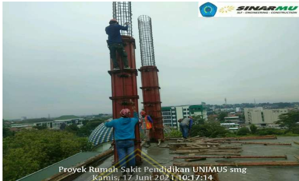
Gambar 4.14 Pekerjaan Instal Bekisting Kolom
