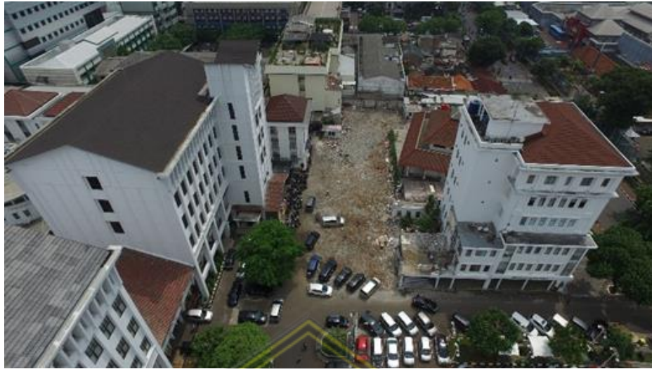
Gambar 4.2 Lokasi Pembangunan Badan POM Jakarta
