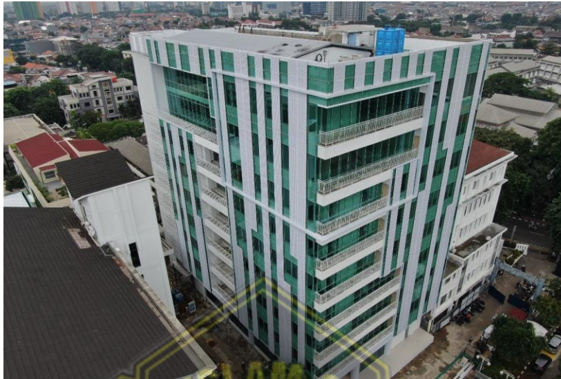
Gambar 4.4 Façade Gedung D BPOM
