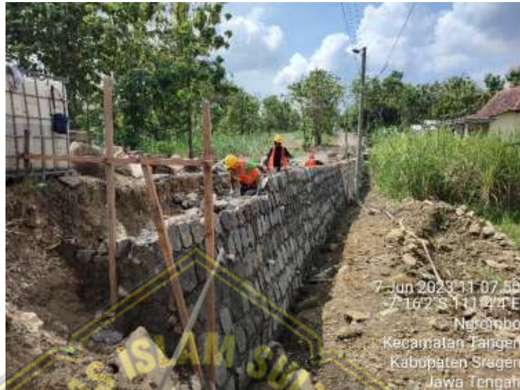
Gambar 4.4 Pekerjaan Struktur Pasangan Batu Kali
