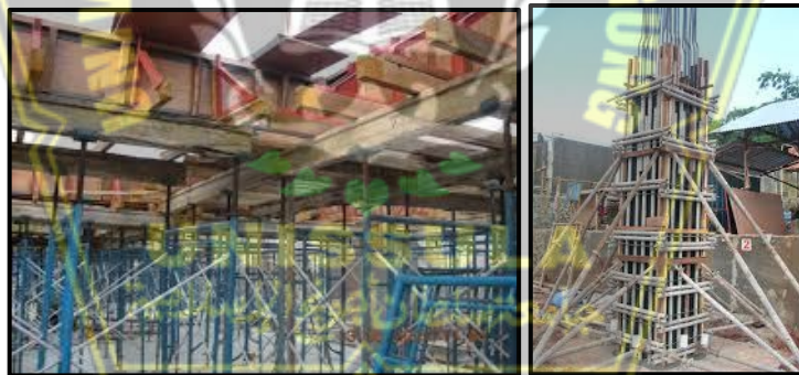
Gambar 2. 3 Pelaksanaan Bekisting Semi Sistem
