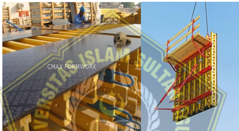
Gambar 2. 8 Pelaksanaan Bekisting Sistem Peri (Sumber : Google Images)
