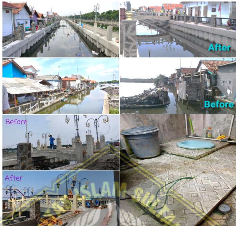
Gambar IV. 2 Perbedaan Kondisi Sebelum dan Sesudah Pelaksanaan Program KOTAKU
