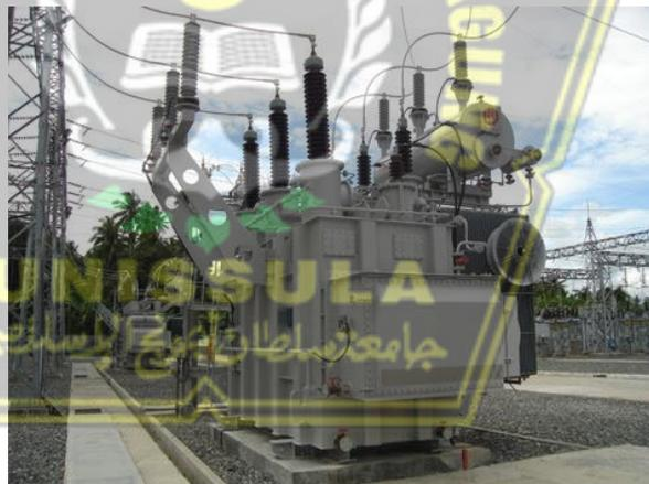
Gambar 2.2 Transformator Gardu Induk Comal
