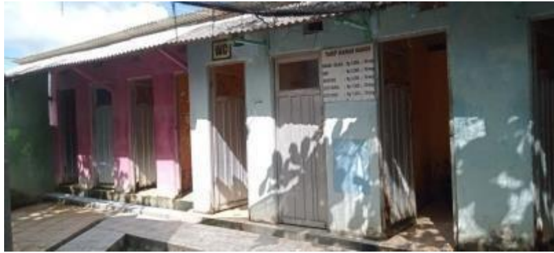
Gambar 3.6 Fasilitas Toilet/WC Umum
