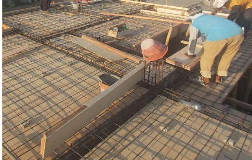
Gambar 4.18. Pembesian Plat Lantai Elv. +4.10
