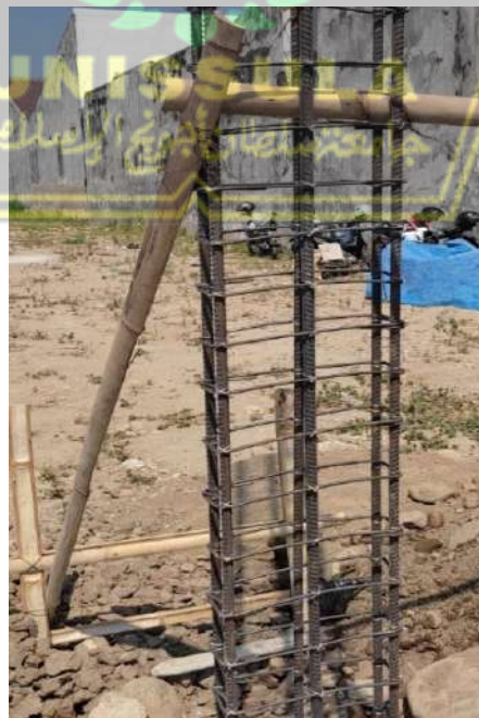
Gambar 4.13. Pembesian Kolom
