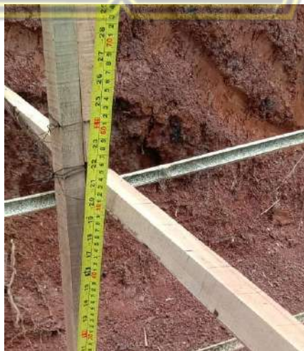
Gambar 4.7. Pengukuran dan Pemasangan Bowplank
