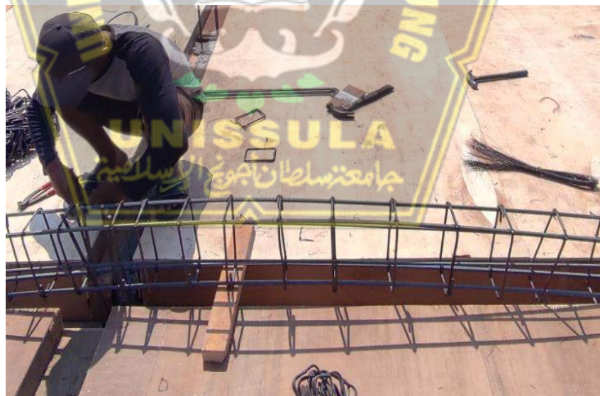
Gambar 4.19. Pembesian Balok Elv. +4.10
