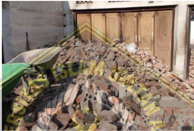
Gambar 4.6. Bongkar Bangunan Eksisting dan Pemuangan
