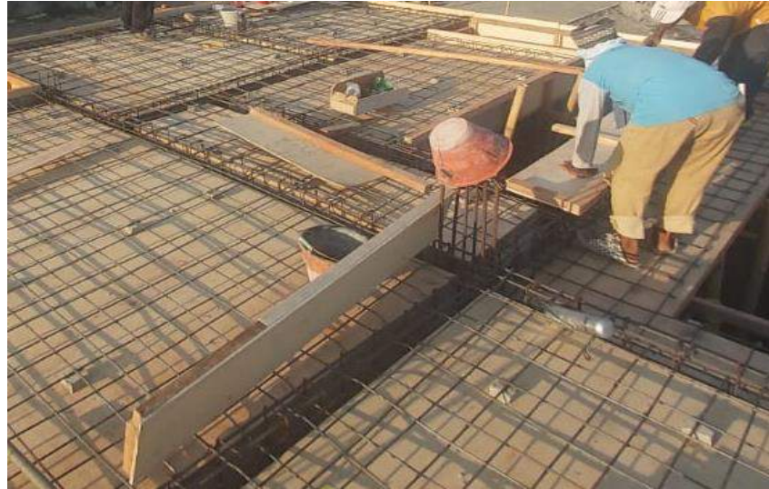
Gambar 4.18. Pembesian Plat Lantai Elv. +4.10
