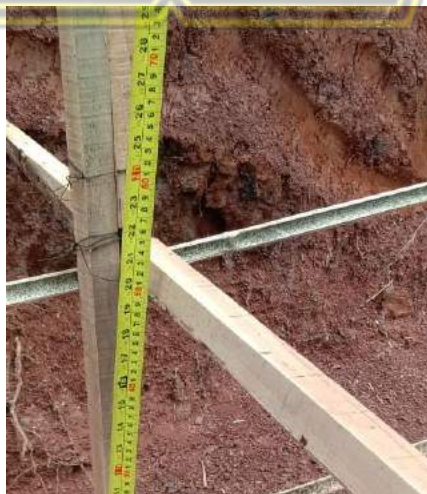
Gambar 4.7. Pengukuran dan Pemasangan Bowplank
