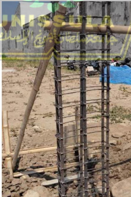
Gambar 4.13. Pembesian Kolom
