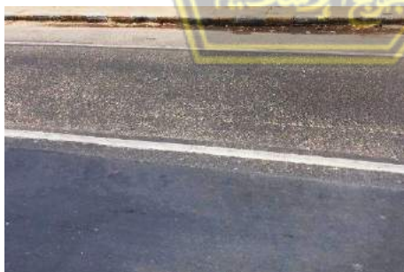
Gambar 4. 1 Pengausan (Sumber: Hasil Survey 16-10-2023)
