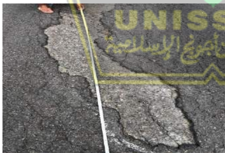
Gambar 4. 10 Pengukuran Dimensi Kerusakan Pelepasan Lapisan (Sumber: Hasil Survey 16-10-2023)
