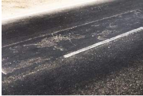
Gambar 4. 3 Pelepasan Lapisan (Sumber: Hasil Survey 16-10-2023)
