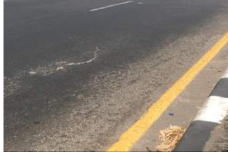
Gambar 4. 30 Kerusakan Pengausan 2+020-2+070 (Sumber: Hasil Survey 16-10-2023)
