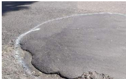
Gambar 2. 19 Kegemukan ( Bleeding/Flushing )
