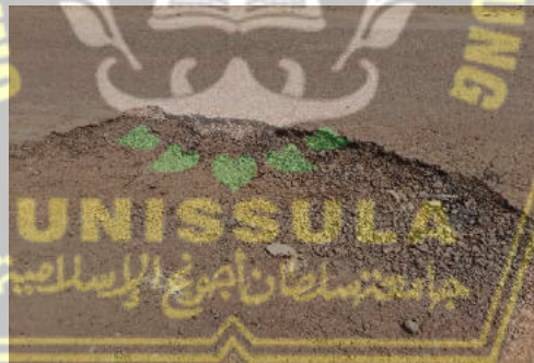
Gambar 2. 16 Pelepasan Butir ( Ravelling )
