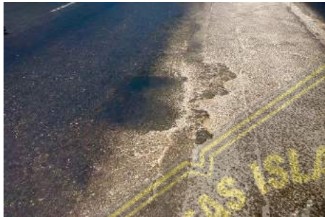
Gambar 4. 5 Kegungkan (Sumber: Hasil Survey 16-10-2023)
