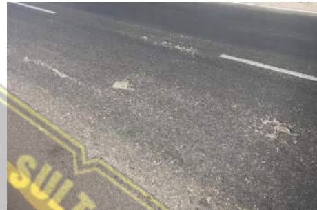
Gambar 4. 6 Lubang (Sumber: Hasil Survey 16-10-2023)
