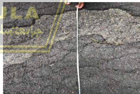
Gambar 4. 11 Pengukuran Dimensi Kerusakan Pelepasan Lapisan (Sumber: Hasil Survey 16-10-2023)
