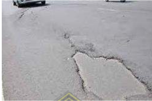
Gambar 2. 17 Pengelupasan Lapisan ( Stripping )
