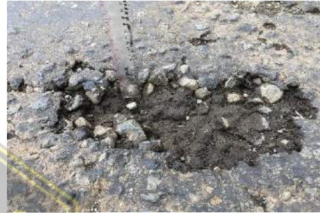
Gambar 4. 9 Pengukuran Kedalaman Kerusakan Lubang (Sumber: Hasil Survey 16-10-2023)
