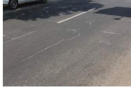
Gambar 4. 4 Retak Memanjang Dan Melintang (Sumber: Hasil Survey 16-10-2023)
