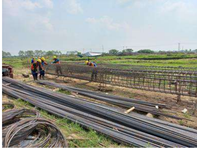
Gambar 2.12 Fabrikasi Pembesian
