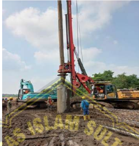
Gambar 2.14 Pemsangan Casing
