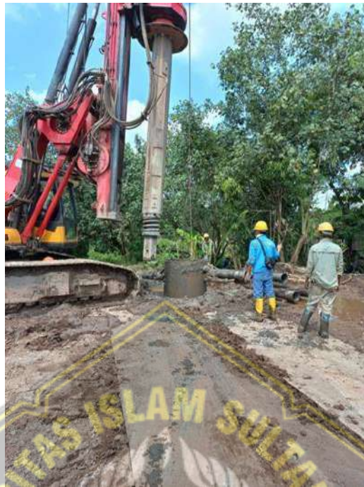
Gambar 2.19 Pencabutan Casing
