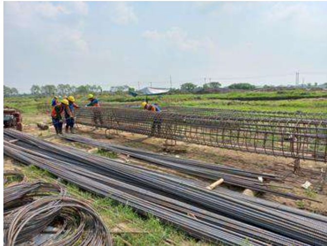
Gambar 2.12 Fabrikasi Pembesian
