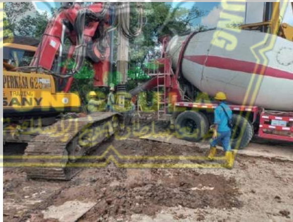
Gambar 2.18 Pengecoran
