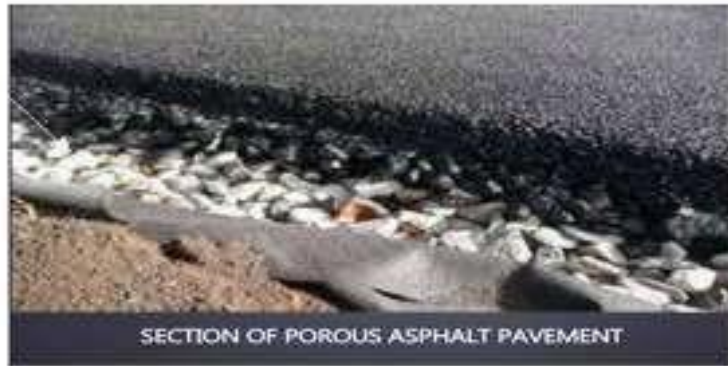
Gambar 2.2 Perkerasan Jalan Menggunakan Aspal Porus
