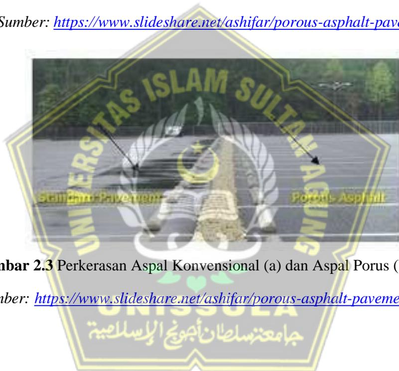
**Gambar 2.3** Perkerasan Aspal Konvensional (a) dan Aspal Porus (b)
