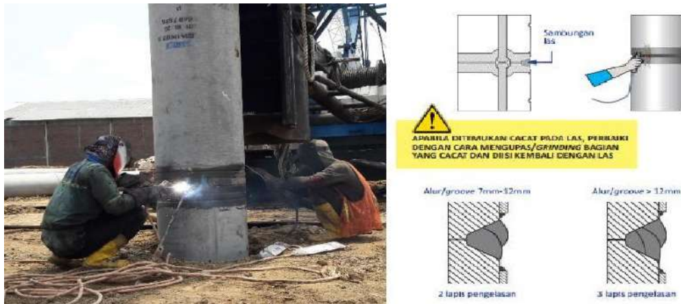
Gambar 2.16 Proses Penyambungan Spun Pile.
