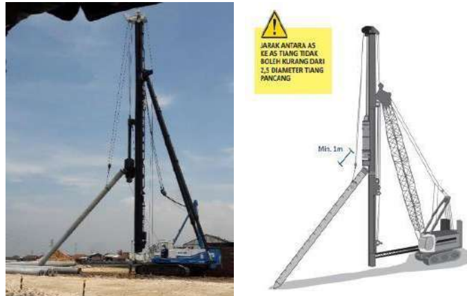
Gambar 2.12 Proses Penegakan Spun Pile.
