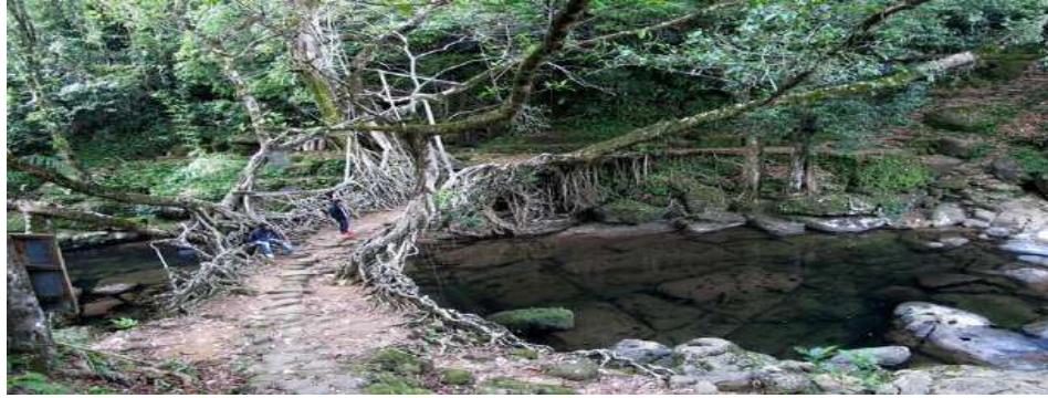
Gambar 2.9 Jembatan The Living
