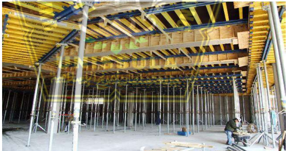
Gambar 2.21 Bekisting Semi Sistem.
