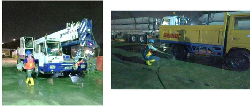
Gambar 4.30 Air Embung untuk Washing bay kendaraan proyek
