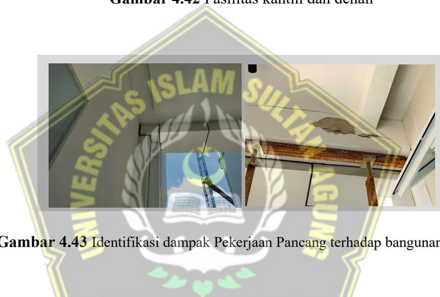
Gambar 4.43 Identifikasi dampak Pekerjaan Pancang terhadap bangunan sekitar
