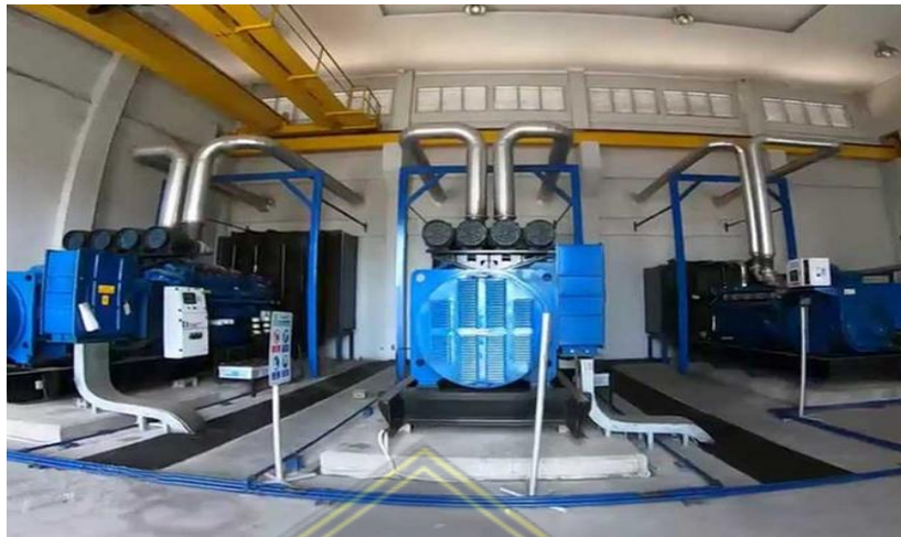
Gambar 2.3 Pompa dan Rumah Pompa PT PELINDO III [14]
