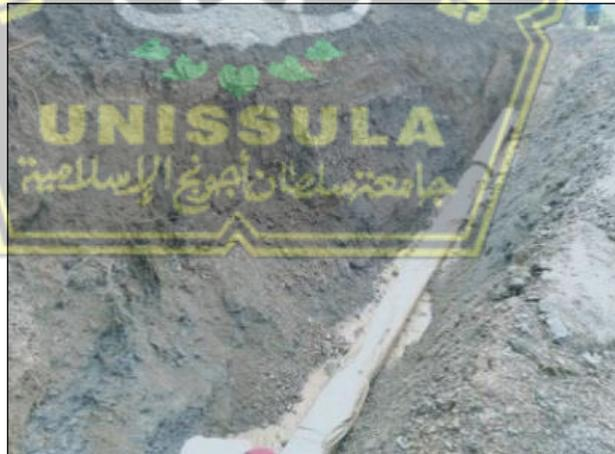
**Gambar 4.5** Pemasangan pipa pvc 5”
