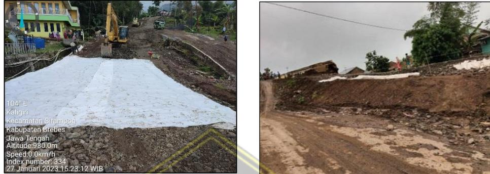
**Gambar 4.4** Pemasangan Geotekstil Stabilisator Kelas 1
