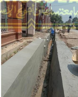
**Gambar IV. 9 Perbaikan Drainase**
